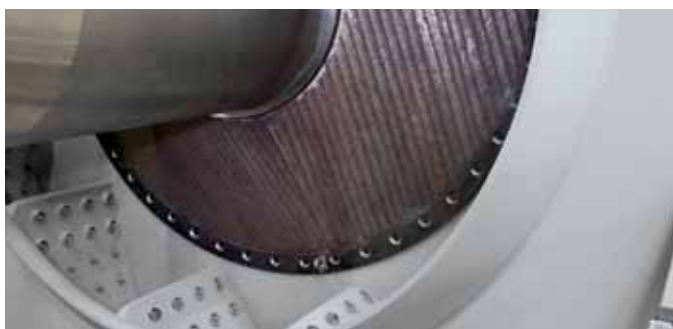
Защитное покрытие фланцевого соединения
